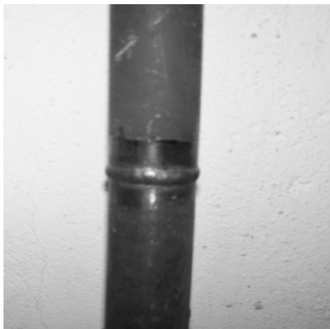
Sl.4 Zavareni spoj čelika 10CrMo9-10 sa čelikom X10CrMovNb9-1.
