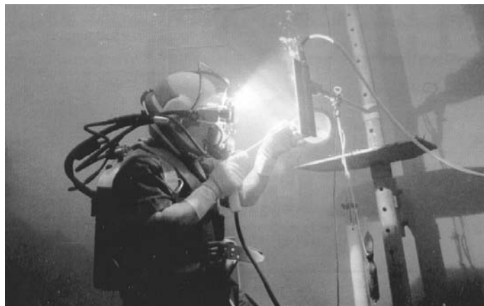
Slika 1. Podvodno mokro zavarivanje [2]
