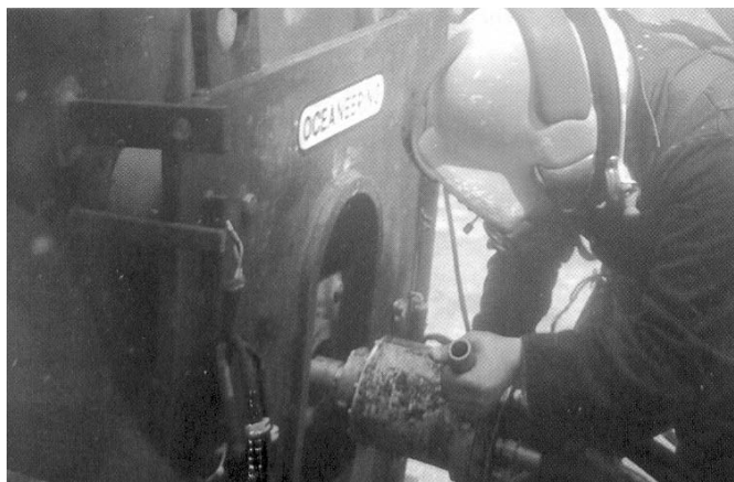
Slika 6. Podvodno zavarivanje trenjem [25]
