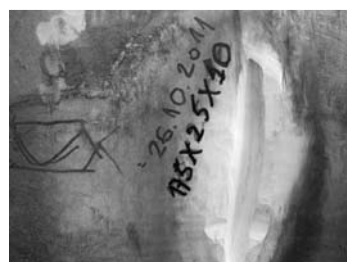
b) Prslina u zavarenom spoju K2 priprmljena za sanaciju
