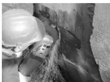
a) Priprema jedne od prslina za sanaciju
