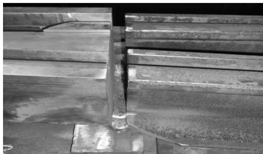
Slika 5. Postavljane bakarnih podmetača za zavarivanje vrata šine za blok
