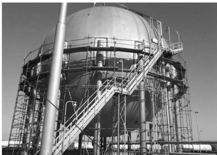
Slika 1. Sferni rezervoar za skladištenje etilena
