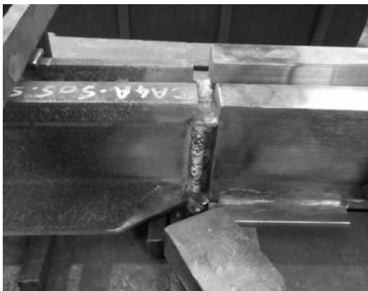
Slika 8. Izgled spoja šina-blok pre navarivanja
