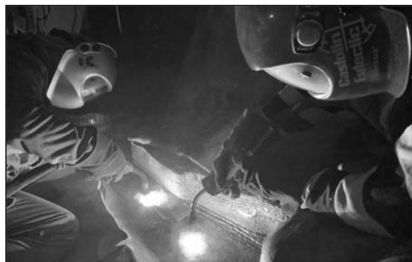
Slika 7. MAG zavarivanje
