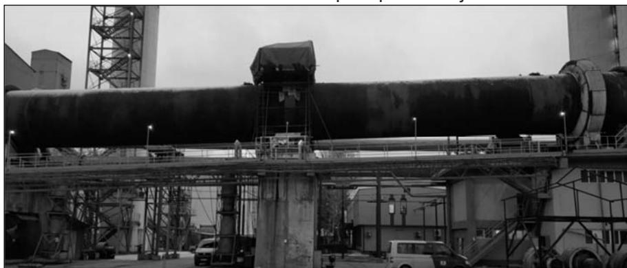
Slika 1. Rotaciona peć – Tvornica cementa d.d. Kakanj
