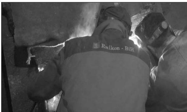
Slika 6. REL zavarivanje – 1/3 šava
