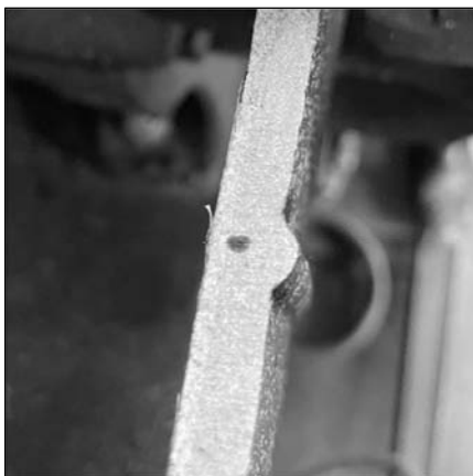
Slika 13. Penetrantska kontrola potvrđuje da nije došlo do kontakta između Ti i čelika u toku zavarivanja
