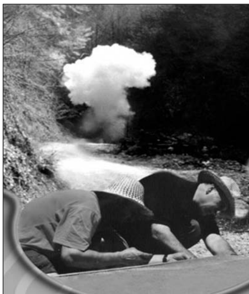
Slika 4. Postavljanje detonirajućeg štapina i trenutak eksplozije
