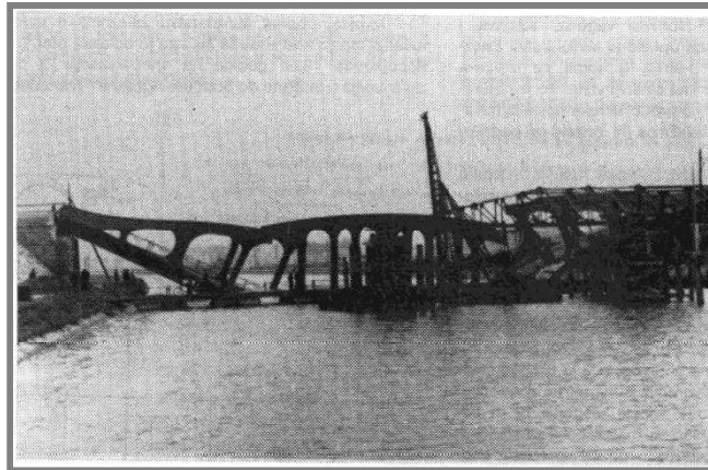
Slika 2: Izgled srušenog mosta kod Haselta u Belgiji [1]
